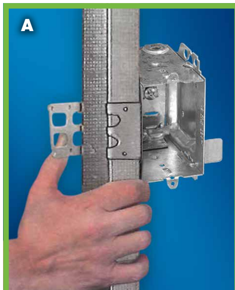
A Positionnez le support enveloppant autour du colombage
