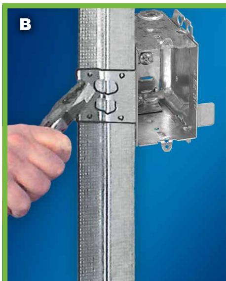
B Fixez le support au colombage à l'aide de pinces
